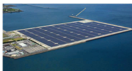
鹿児島七ツ島メガソーラー発電所
