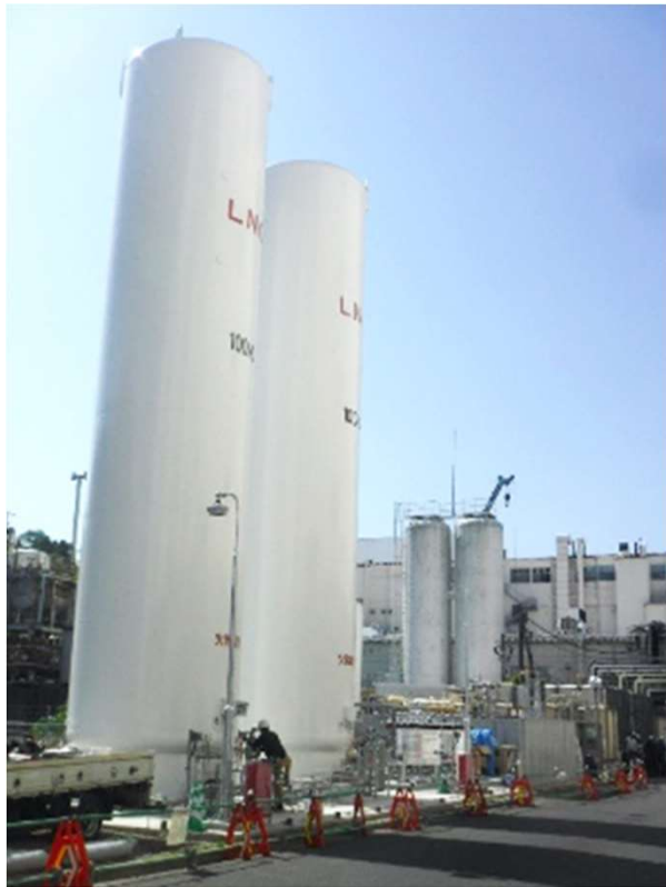
ガス貯蔵施設の建設工事の様子
